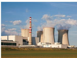
发电厂综合自动化系统
