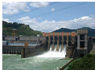
水电站综合自动化系统
